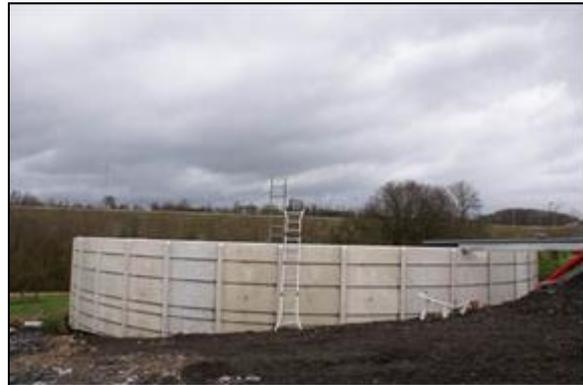
béton – éléments préfabriqués
