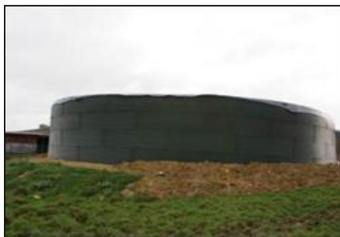
avec armature – tôles ondulées
